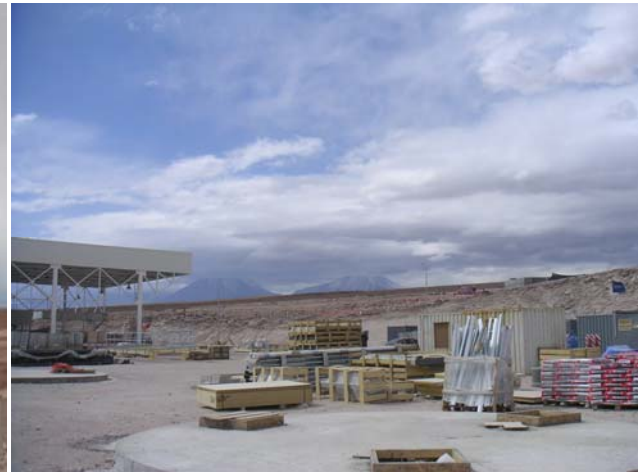
▲建設中の山麓基地(2007年9月)
