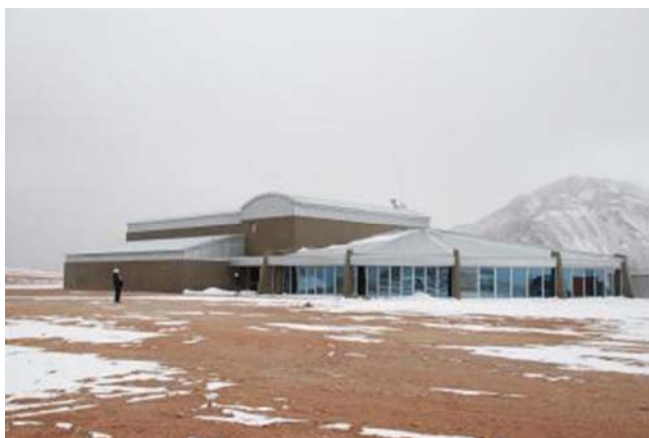
▲山頂基地の建物(2007年9月、この時未だ建物内は与圧されていなかった)
