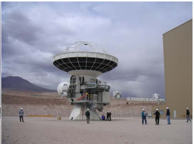
▲アメリカのアンテナ(右は組み立て棟、 資材庫)(2007年9月)
